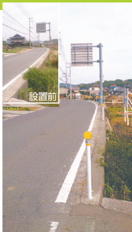
路側帯の安全対策反射鏡設置(神辺町道上)
