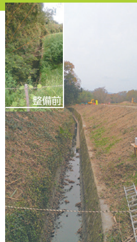
水路付近周辺整備(駅家町向永谷)
