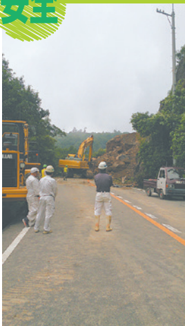
182号線の土砂災害現場を視察
