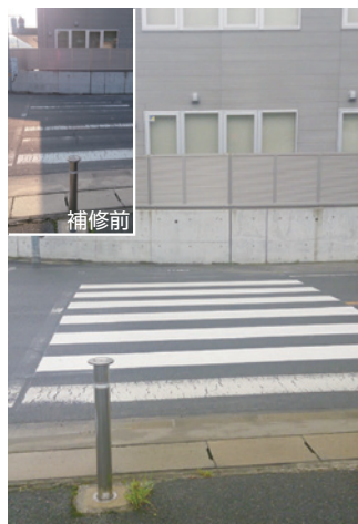
横断歩道表示補修(新市中央中学校付近)
