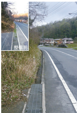
県道側溝の整備
